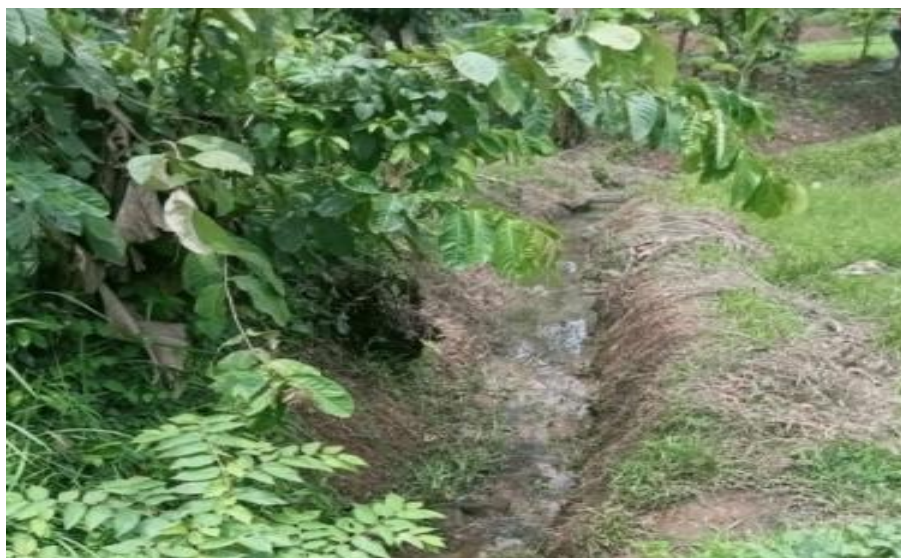
Gambar 2 Aliran irigasi ke Dusun 3 yang mengalami pendangkalan Sumber: Dokumentasi pribadi penulis (2024)
